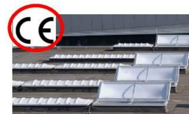
Evacuatori naturali di fumo e calore
