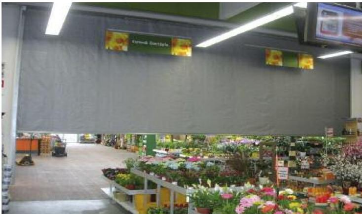
Barriera mobile DH120 a chiusura tra due reparti in un centro commerciale
