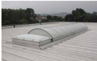
COPERTURA METALLICA AGRAFFATA CRIMPED METAL ROOFING
