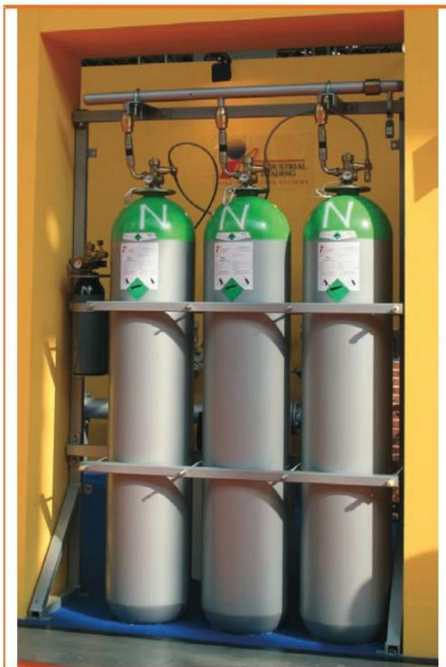
Il sistema ad IG 55 è un sistema di spegnimento a saturazione totale che utilizza una miscela di Argon e Azoto presenti normalmente in atmosfera, in rapporto 1:1. La miscela agisce sull'incendio diminuendo la concentrazione di ossigeno nell'area protetta ad un valore che impedisce la combustione, senza intaccare la sicurezza del personale presente. Il sistema non ha alcun impatto ambientale, nessun effetto di depauperamento della fascia di ozono (ODP=0 e Gwp=0).
