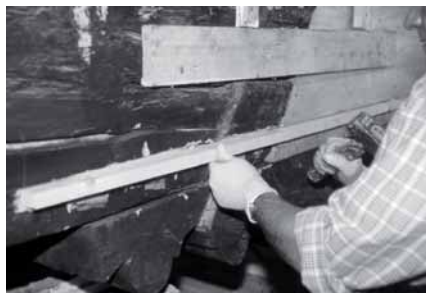
5 - Inserimento dei listelli all'interno del canale
