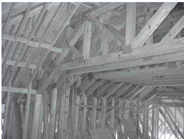
Figura 4.32 : Travi reticolari di copertura in un edificio Platform frame collegate con piastre dentate.
