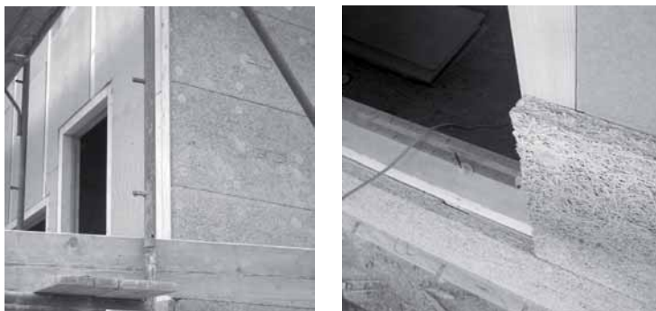
Figura 5.106: Casa per civile abitazione con struttura in pannelli a strati incrociati, cappotto esterno in fibra di legno e pannelli in lana di legno mineralizzata (Casa Mazza, Linguaglossa, Catania).
