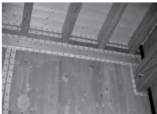
Figura 5.70: Le sigillature evitano i punti di ingresso d'aria non controllato. Sono fondamentali per la durabilità, il bilancio energetico e il comfort ambientale.
