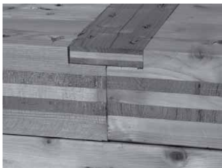
Figura 5.144: Collegamento orizzontale fra pannelli solaio.
