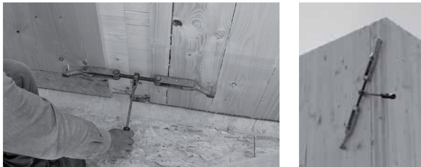
Figura 5.8: Serraggio dei pannelli parete con tiratravi.
