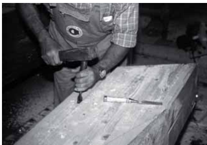
2 - Realizzazione dei canali di alloggiamento delle barre e asportazione del legno inciso con lo scalpello.
