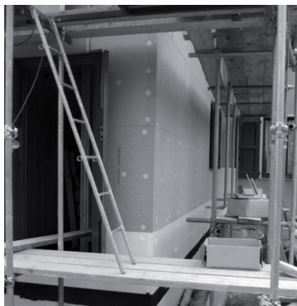
Figura 5.129: L'edificio, realizzato con struttura a pannelli di legno massiccio a strati incrociati, è rivestito con pannelli di fibra di legno aderenti alla struttura; il successivo strato di intonaco rende la superficie non infiammabile e impedisce la propagazione del fuoco in facciata.
