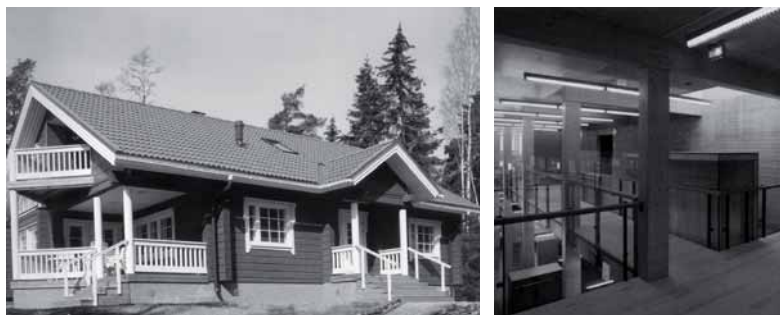
Figura 4.52: A sinistra un edificio Log House e a destra un edificio intelaiato. Per questi sistemi costruttivi si trovano poche indicazioni sia sui valori di progetto sia sulle indicazioni costruttive per la progettazione in zona sismica.
