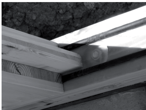
Figura 5.5: Posizionamento di uno strato di gomma al contatto fra parete e cordolo.
