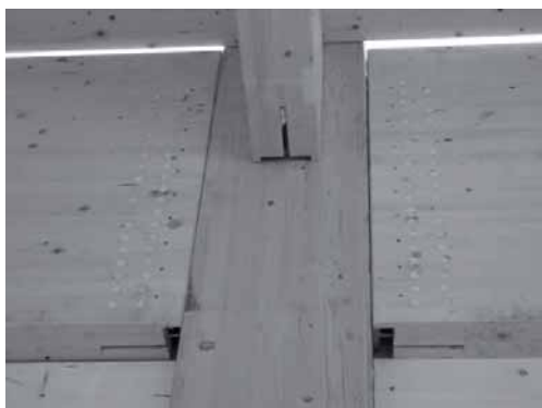
Figura 5.143: Collegamento fra trave e pilastro; si notino i tappi di legno di protezione al fuoco sulle teste degli spinotti; mancano ancora le tavolette di ripristino e i tagli delle lavorazioni all'intradosso.
