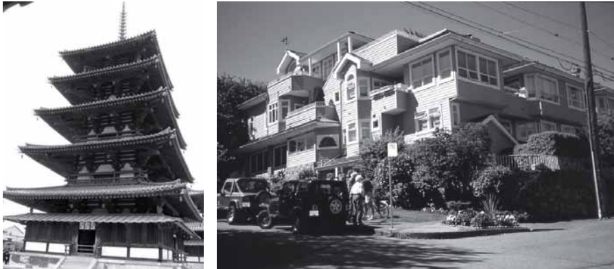
Figura 4: A sinistra: pagoda del tempio di Horyu-ji a Nara, Giappone, anno di costruzione 607 d.c., 5 piani, 31,5 m di altezza. A destra: edificio di 3 piani a Vancouver, B.C., Canada. Alcuni di questi edifici, interamente a struttura di legno, arrivano a 4 piani e superano i 100 anni di vita.
