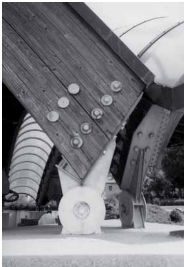
Figura 4.4: la notevole estensione dell'unione metallica in direzione ortogonale alla fibratura non permette al legno, esposto alla pioggia ed al sole, di ritirarsi liberamente, pertanto si è generata una fessura completamente passante la sezione. Sarebbe stato più opportuno limitare l'estensione della piastra in direzione ortogonale alla fibratura estendendola in direzione parallela.
