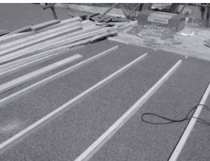
Figura 5.83: La prima listellatura in pendenza viene posata sul primo strato di coibentazione continuo; fra un listello e l'altro viene posato il secondo strato di coibentazione. La prima listellatura viene fissata con viti che passano il listello, i primo strato di coibentazione ed il tavolato e raggiungono le sottostanti travi.
