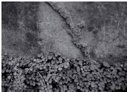
Figura 2.22: galleria di collegamento su di un muro realizzata dalle termiti per raggiungere le parti di legno senza esporsi alla luce.
