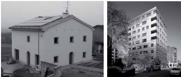
Figura 1: A sinistra: edificio di due piani realizzato dall'Ing. G. Moschi a Scarperia (FI). Tempo di montaggio delle strutture: 4 giorni. A destra: edificio interamente a struttura di legno di 9 piani realizzato nel 2008 a Murray Grove, Londra su progetto dello studio Waugh-Thistleton. Tempo di realizzazione delle strutture: 9 settimane.
