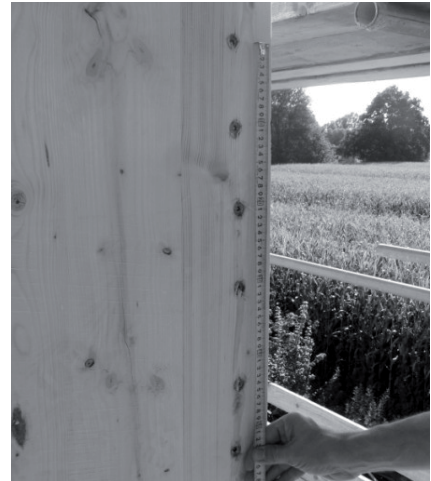
Figura 5.142: Collegamento verticale fra pareti ortogonali.
