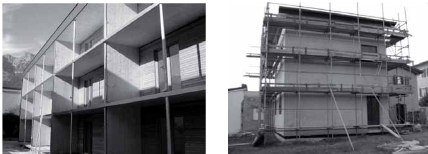
Figura 5.1: Edificio condominiale a tre piani e edificio monofamiliare a due piani con struttura a pannelli portanti (Foto Claudio Cavazzuti).
