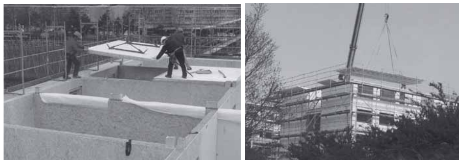
Figura 5.47: Casa dello studente a Losanna (CH). Fasi costruttive.
