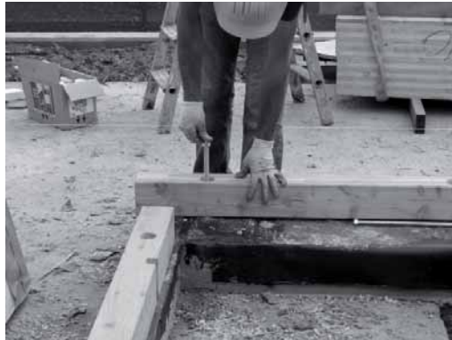
Figura 5.75: Sulla soletta di fondazione viene realizzato un cordolo di calcestruzzo, su di esso un foglio di guaina bituminosa per prevenire la risalita capillare, un cordolo di larice (legno naturalmente durabile); la parete viene fissata sul cordolo di larice.
