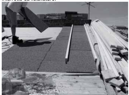
Figura 5.83: La prima listellatura in pendenza viene posata sul primo strato di coibentazione continuo; fra un listello e l'altro viene posato il secondo strato di coibentazione. La prima listellatura viene fissata con viti che passano il listello, i primo strato di coibentazione ed il tavolato e raggiungono le sottostanti travi.
