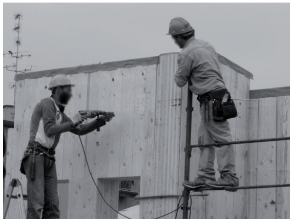
Figura 5.121: L'utilizzo di casco, guanti e calzature di sicurezza è fondamentale nelle fasi di costruzione di un edificio di legno.
