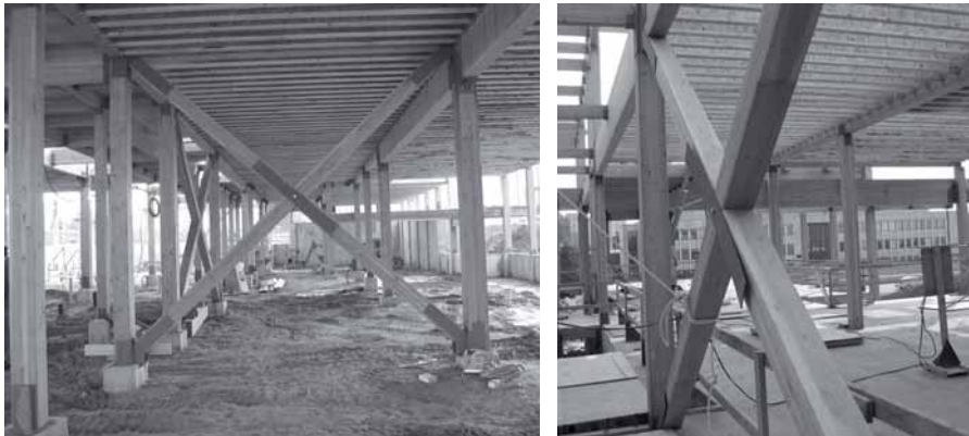
Figura 5.22: Edificio commerciale con fondazione su plinti in c.a. (fonte www.cwc.ca).
