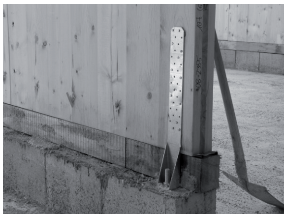
Figura 5.137: Collegamento delle pareti alle fondazioni con interposizione di cordolo in legno massiccio di larice. Da notare che le pareti non poggiano direttamente sulla platea di fondazione ma su di un rialzo realizzato con blocchi-cassero di calcestruzzo, tale rialzo costituisce circa lo spessore dei vari strati (riempimenti, sottofondi, massetti, pavimento) e pertanto il legno non risulterà mai al disotto del pavimento finito conferendo quindi durabilità all'opera.
