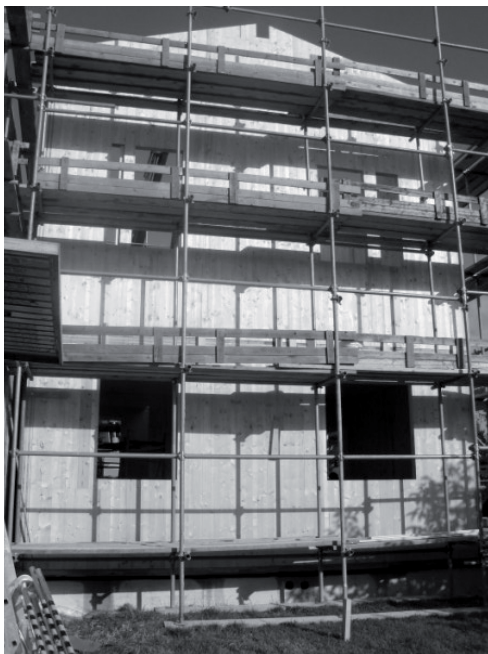
Figura 5.122: Ponteggio montato a servizio di un edificio a struttura di legno (foto Claudio Cavzzuti).
