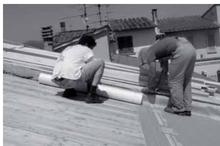
Figura 5.82: Sul tavolato di copertura viene posata una prima guaina antivento ad alta traspirabilità, questa può essere anche una semplice carta oleata. La guaina viene srotolata a fasce orizzontali partendo dalla gronda in modo che il foglio più in alto sormonti quello più in basso. Viene fissata solo sul bordo superiore mediante chiodi a testa larga; la chiodatura viene coperta dal sormonto. In periodi particolarmente caldi è bene proteggersi dall'irraggiamento solare durante le operazioni di posa.
