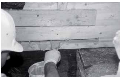
4 - Inserimento della barra di acciaio.
