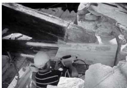
7 - Dopo 24 ore di maturazione della colla si può eseguire la piallatura per asportare la malta epossidica in eccesso e regolarizzare le superfici.
