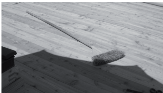
Figura 5.118: La pulizia frequente del cantiere dai trucioli derivanti dalla lavorazione e dal montaggio delle strutture e il loro smaltimento è una operazione molto importante per evitare il rischio di propagazione di incendio.
