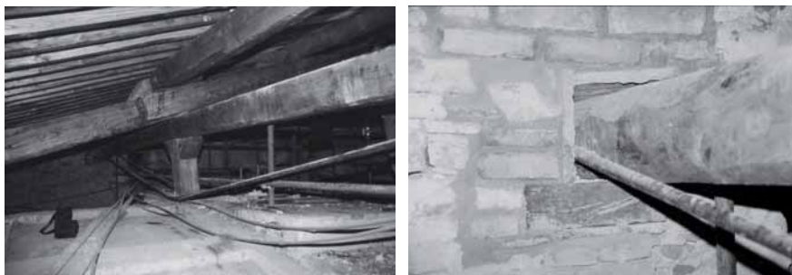
Figura 5.136: – La trave di spina di questo tetto gravava sulla sottostante volta originariamente non destinata a portare il peso della copertura; tale appoggio è stato sostituito da una coppia di tiranti metallici ancorati sulle testate della trave; è stato diminuito il rischio di attacco biologico sulle testate realizzando l'appoggio su dormiente di legno duro ed una intercapedine di aerazione. (Villa privata in Siena).
