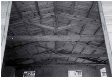
Capriate e strutture di copertura montate. Da notare la catena formata da due elementi collegati con un giunto meccanico realizzato con viti.
