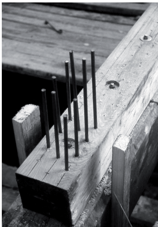
Figura 5.133: Trave rinforzata mediante la messa in opera di un nuovo elemento di legno superiore giuntato con spinotti metallici a formare una sezione composta legno-legno. (Porta San Pietro in Lucca).
