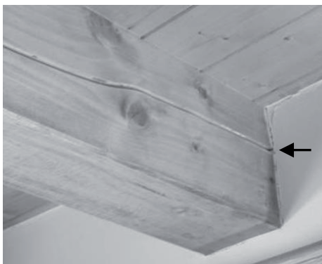
Figura 5.71: Le precauzioni costruttive da progettare e realizzare attorno ad una testata, di trave o capriata per evitare lo sviluppo di carie e la fessurazione dell'intonaco, sono molto semplici: lasciare spazio dietro la sezione trasversale e circondare le parti inserite nel muro, per le quali può essere utile anche un trattamento preservante preventivo più accurato e ripetuto dopo eventuali tagli per la posa, con materiale drenante ed elastico (ad es. sughergomma). In passato, ciò si faceva mediante tavolette di legno più durabile (larice, quercia, castagno...). Una fessura da ritiro come quella visibile nella foto è fisiologica e non costituisce un problema statico: ad esempio, la norma DIN 4074 ammette fessure fino al 50% della larghezza per la categoria S10 (C24).
