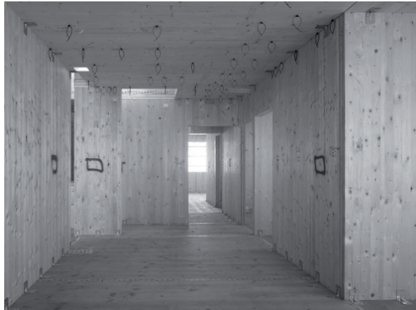
Figura 5.40: Vista dell'interno delle strutture dell'edificio durante la costruzione.
