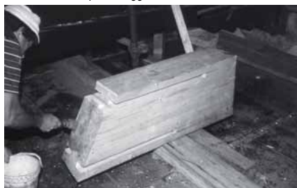
3 - Trattamento della protesi con prodotto insetticida e fungicida, avendo cura di non applicare il prodotto nei canali per non pregiudicare il successivo incollaggio.
