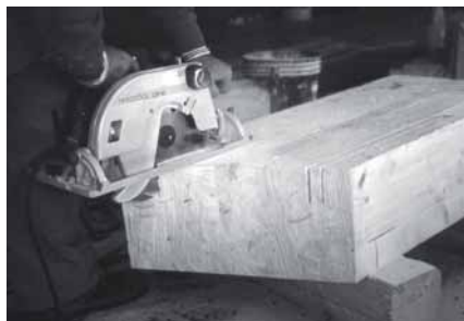
1 - Lavorazione della protesi con una sega circolare per tracciare i canali per l'alloggiamento delle barre.
