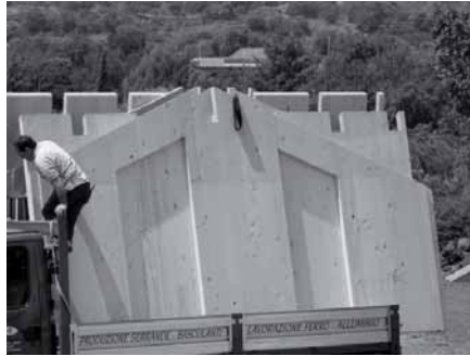
Figura 5.120: La numerazione dei pannelli e il loro corretto posizionamento per il trasporto è fondamentale per velocizzare le fasi di montaggio successive, come anche l'ordinato accatastamento dei contenitori della ferramenta.
