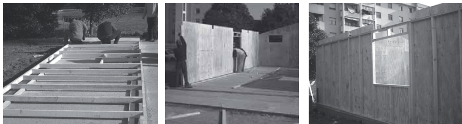
Figura 5.15: Montaggio di una parete a piè d'opera e collegamento alla fondazione.
