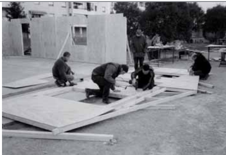
Assemblaggio a terra della parete frontale.
