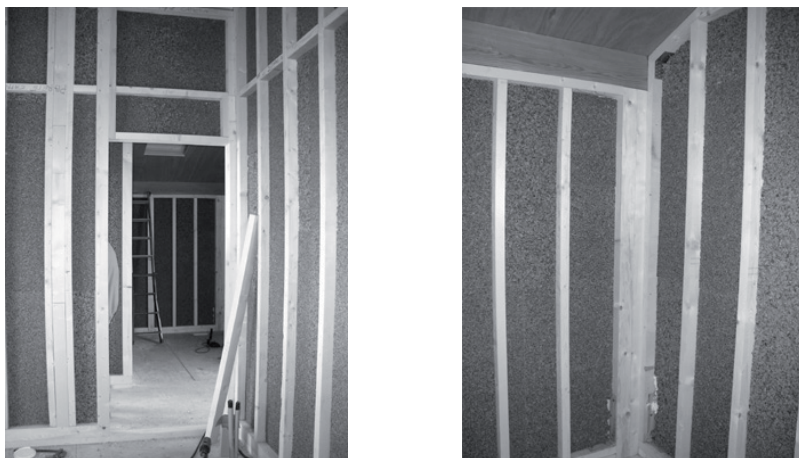
Figura 5.19: Posizionamento dell'isolante all'interno dell'intercapedine delle pareti (foto Valerio Rao).
