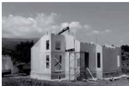
Figura 5.37: Fasi costruttive dell'edificio. Tempi di realizzazione delle sole strutture: 4 giorni.
