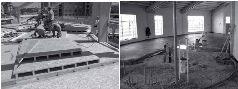
Figura 5.51: Nidi nel Verde, Roma. Da sx: fasi realizzative dei solai: chiodatura degli elementi a cassone in legno massiccio e OSB; getto del massetto flottante su letto di sabbia.
