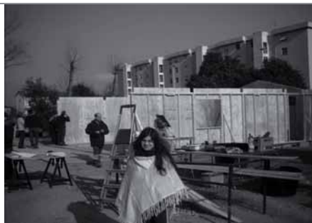
Fasi di posizionamento delle pareti.
