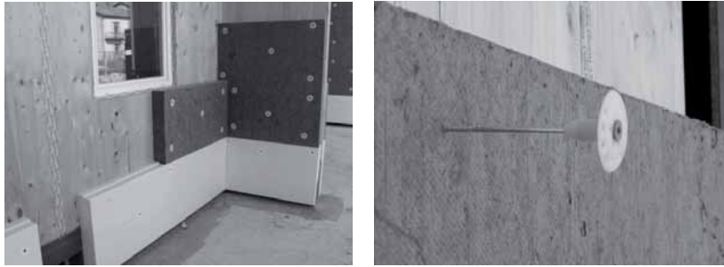
Figura 5.74: Sulle pareti portanti realizzate con il pannello di legno massiccio a strati incrociati è posata una lana di roccia a pannelli rigidi di densità 150kg/m 3 ; il fissaggio avviene mediante apposite viti fornite di rondella larga fornite di tappo "anti ponte termico". Lo zoccolo in basso viene realizzato mediante pannello sintetico impermeabile in quanto la parte bassa della parete può essere bagnata dalla pioggia che rimbalza sulla pavimentazione esterna.
