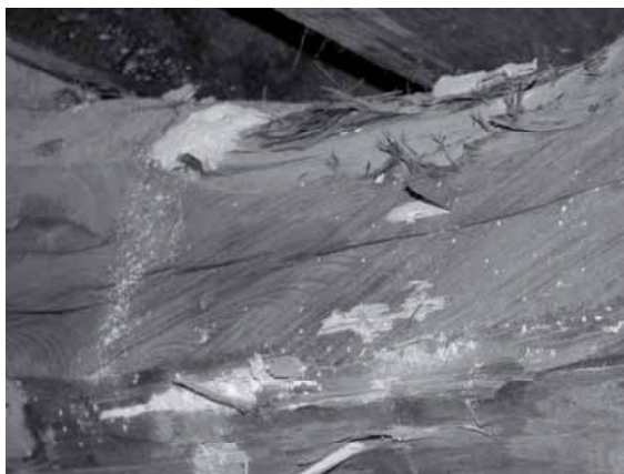
Figura 2.20: Attacco in atto di cerambicidi e di anobidi (fori piccoli).
