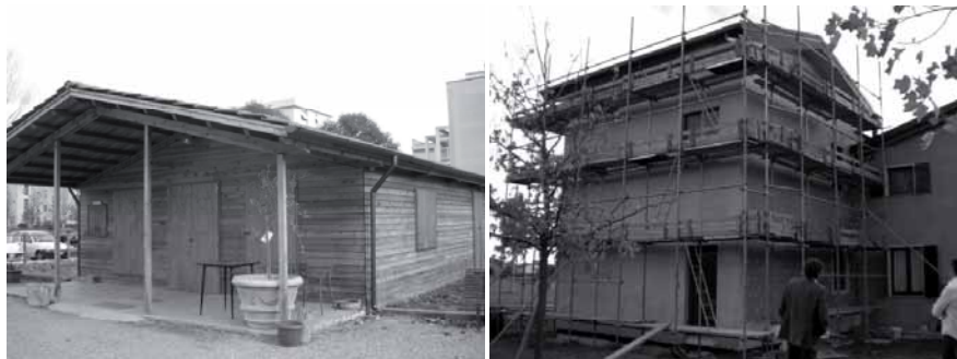
Figura 5.73: a sinistra finitura esterna con doghe in legno, a destra finitura con intonaco.
