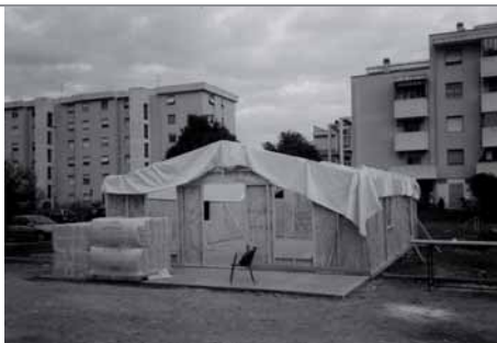
Montaggio pareti completato.
