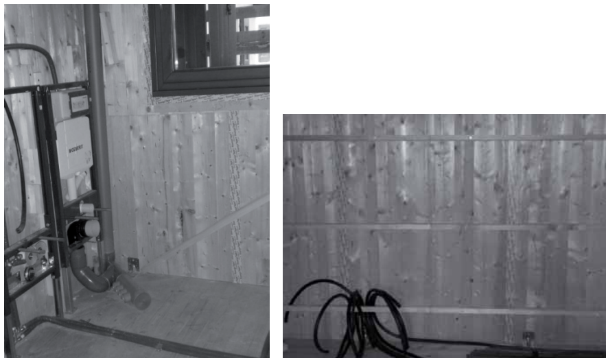
Figura 5.77: Posa degli impianti sulla parete strutturale.
