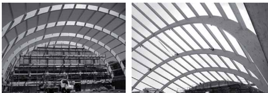
Figura 4.2: Struttura progettata nell'ipotesi di comportamento scarsamente dissipativo (archi a 3 cerniere), q=1,5 . Foto Franco Mori.
