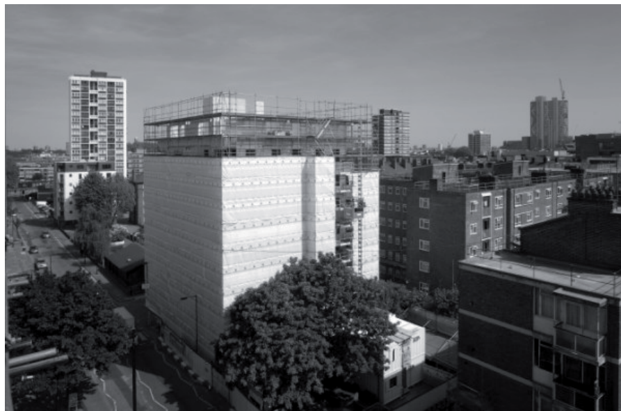
Figura 5.39: Fase costruttiva dell'edificio.
