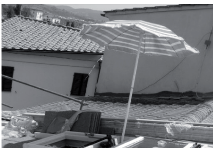
Figura 5.82: Sul tavolato di copertura viene posata una prima guaina antivento ad alta traspirabilità, questa può essere anche una semplice carta oleata. La guaina viene srotolata a fasce orizzontali partendo dalla gronda in modo che il foglio più in alto sormonti quello più in basso. Viene fissata solo sul bordo superiore mediante chiodi a testa larga; la chiodatura viene coperta dal sormonto. In periodi particolarmente caldi è bene proteggersi dall'irraggiamento solare durante le operazioni di posa.
