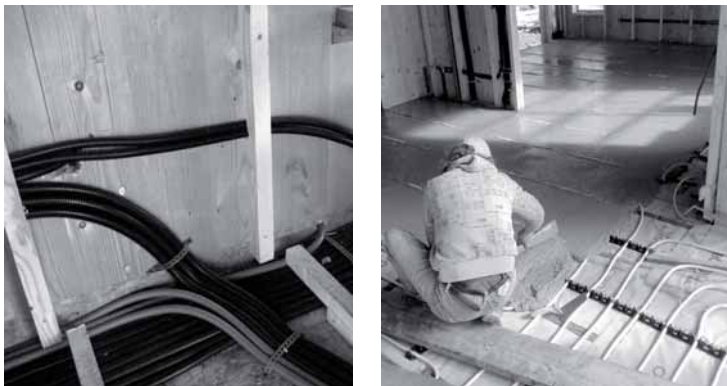
Figura 5.114: A destra: continuità distributiva fra piano e parete di impianto elettrico (Casa Mazza, Linguaglossa, Catania.) A sinistra: massetto porta impianti in calce idraulica armato con fibre in polipropilene per impianto radiante a pavimento (Casa Mazza, Linguaglossa, Catania).
