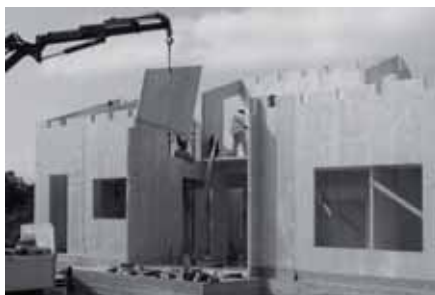
Figura 5.37: Fasi costruttive dell'edificio. Tempi di realizzazione delle sole strutture: 4 giorni.
