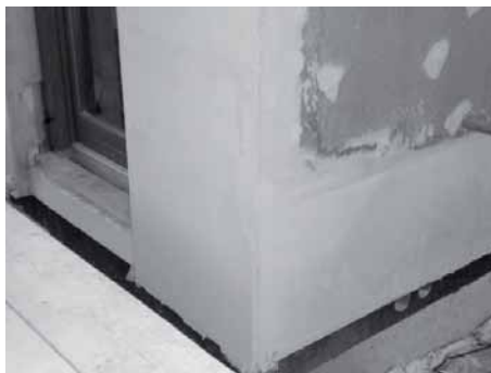
Figura 5.129: L'edificio, realizzato con struttura a pannelli di legno massiccio a strati incrociati, è rivestito con pannelli di fibra di legno aderenti alla struttura; il successivo strato di intonaco rende la superficie non infiammabile e impedisce la propagazione del fuoco in facciata.
