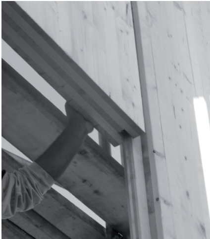
Figura 5.141: Collegamento verticale fra pannelli parete.
