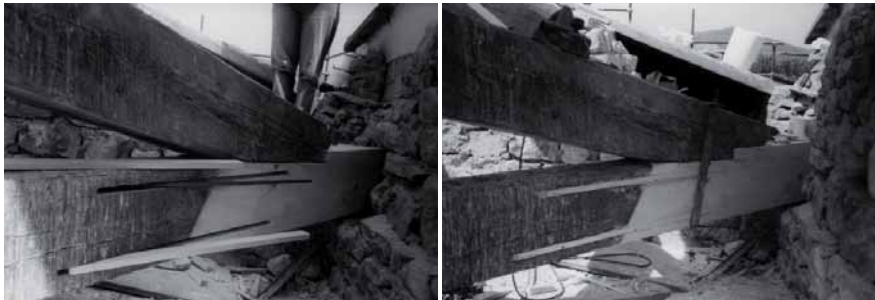
Figura 5.135: La testata cariata di una capriata di copertura è stata sostituita in poche ore con una protesi di legno giuntata con barre di acciaio incollate con malta epossidica; la foto a sinistra mostra la prova degli elementi di giunzione (barre e listello di chiusura) prima dell'incollaggio. (Chiesa di Santo Stefano in Pane a Firenze).
