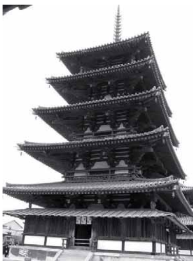
Figura 4.50: Pagoda di Horiu-ji a Nara, oltre 30m di altezza, costruita circa 1.400 anni fa. Esempio mirabile di struttura insieme leggera, resistente e flessibile che ha resistito indenne a secoli di terremoti distruttivi.
