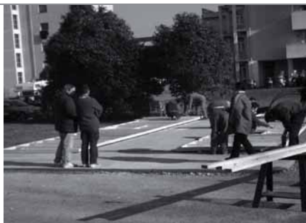
Assemblaggio dei telai delle pareti a terra.
