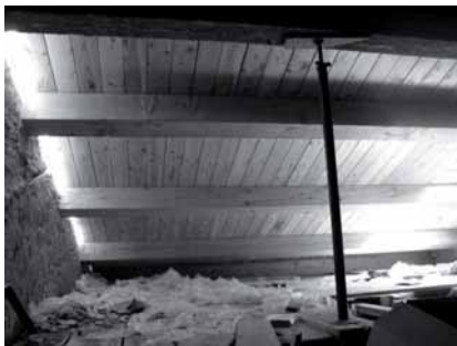
Figura 5.81: La struttura del tetto può essere facilmente e rapidamente costruita mediante travi e tavolato. Il legno a vista nei sottotetti è particolarmente gradevole.
