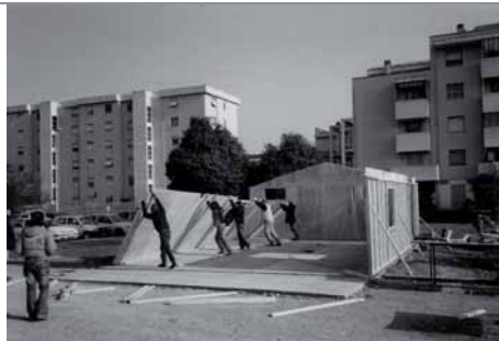
Sollevamento della terza parete.
