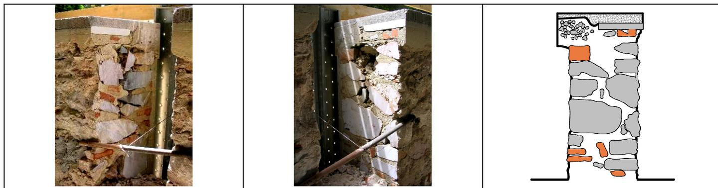
Figura 2. Foto e rilievo della tessitura muraria.
