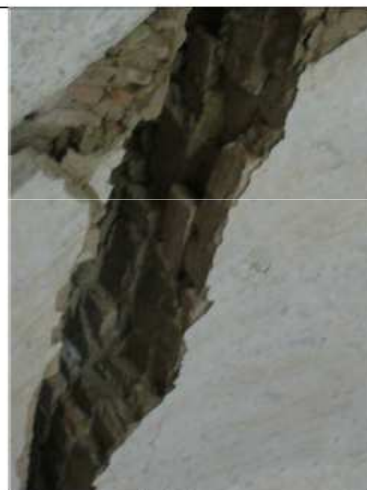
Figura 9: Dettaglio dello spessore e tessitura della volta
