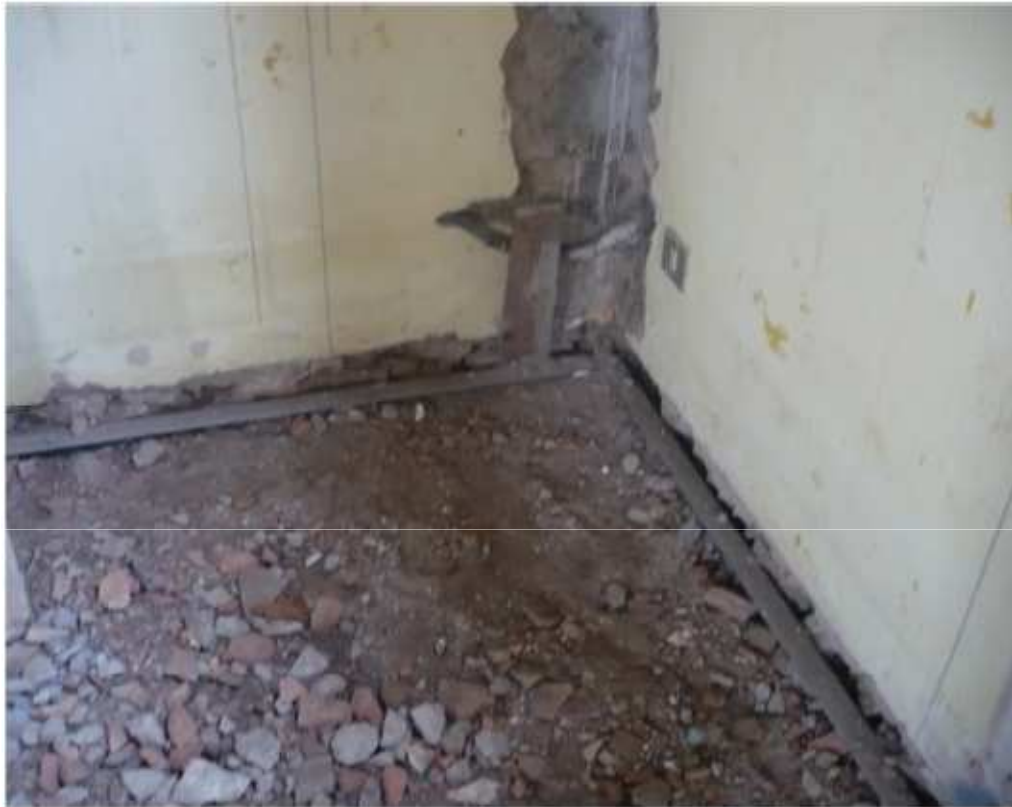
Fig. 7. 7: Ripristino del riempimento originario delle volte
