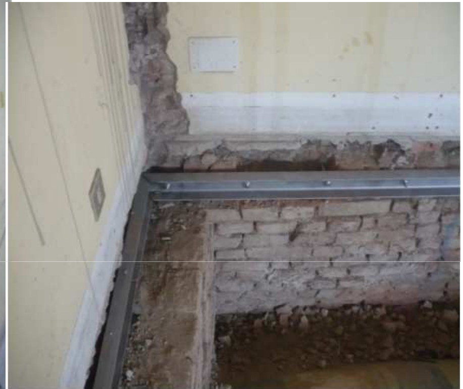
Fig. 7. 6: Particolare cerchiatura del primo solajo mediante UPN 80
