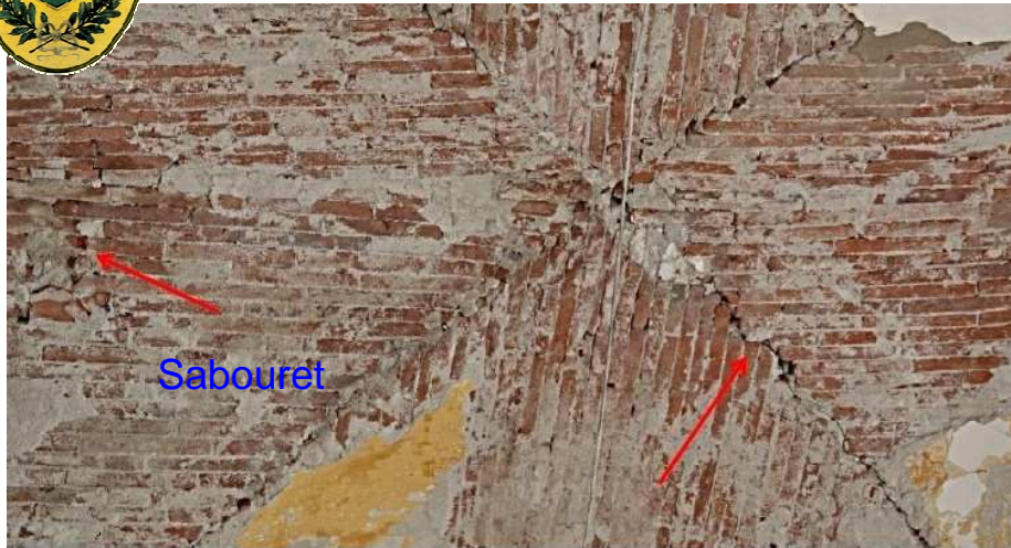
Figura 4: Lesioni archi diagonali, intradosso.
