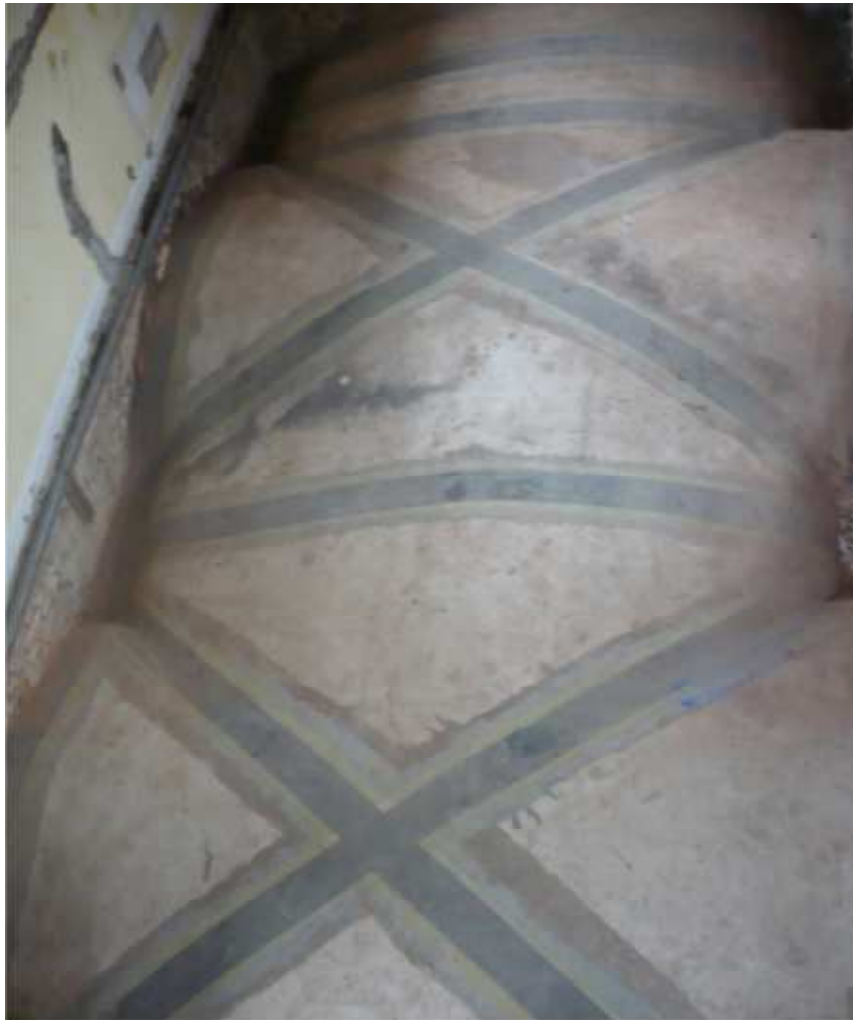
Fig. 7. 4: Consolidamento delle volte mediante fibre di vetro e di carbonio all'estradosso
