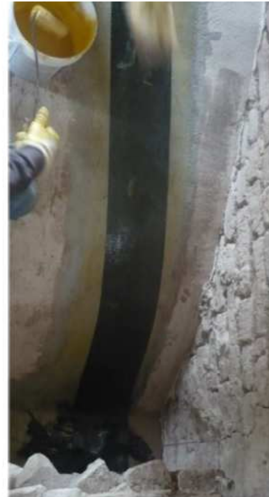
Fig. 7. 5: Particolare posa in opera delle fibre di carbonio
