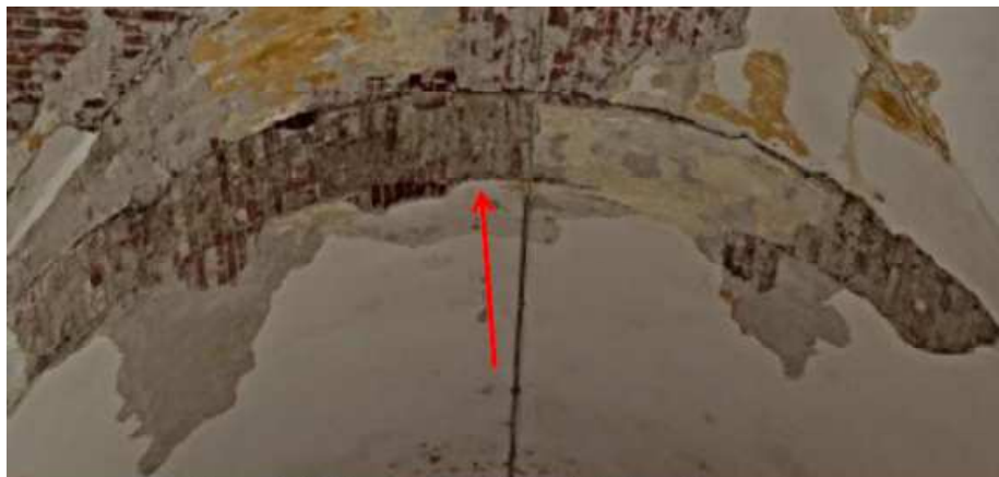
Figura 5: Distacco arcone di bordo della volta a crociera
