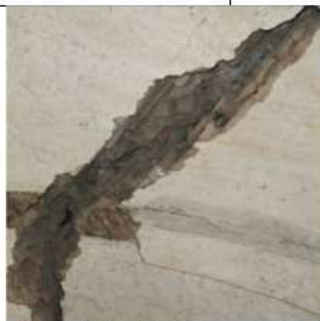
Figura 11: Probabile riempimento della volta con mattoni
