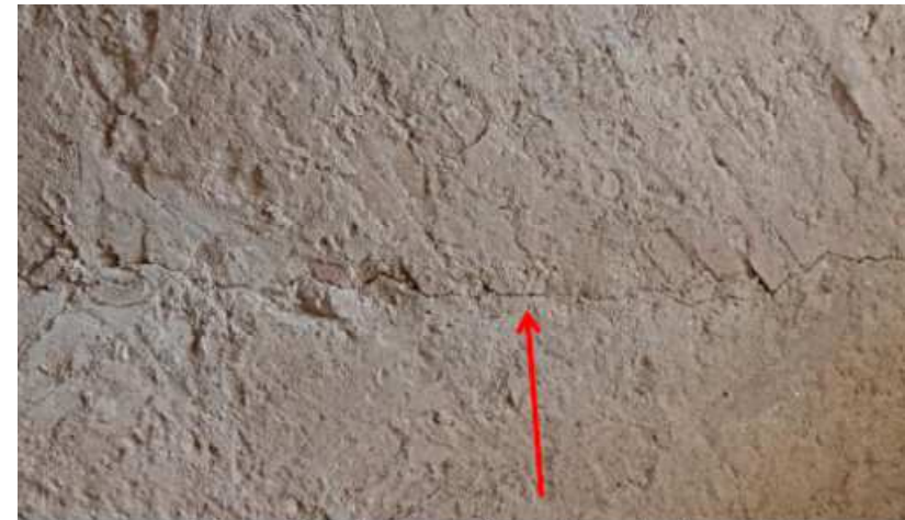
Figura 3: Lesione arco diagonale, estradosso
